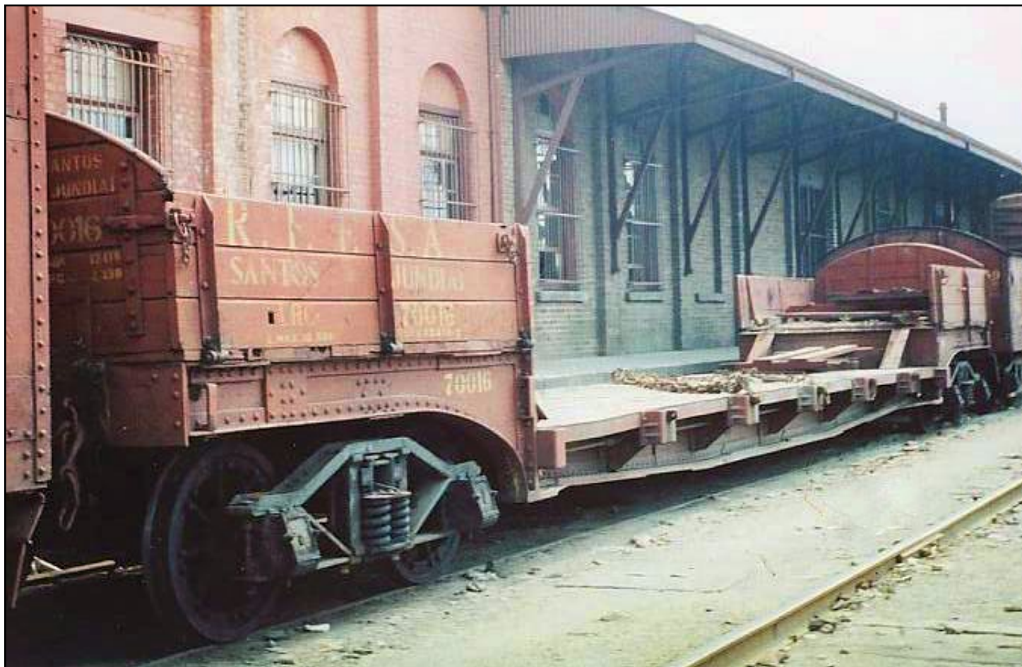
2. A outra prancha rebaixada originária da SPR aqui vista já na fase RFFSA/SR4. Foto de José Pascon.
