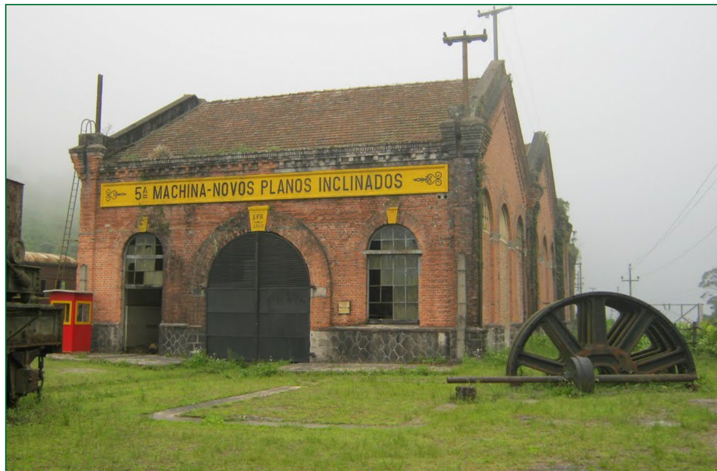
O prédio da antiga 5ª máquina do sistema funicular hoje abriga o museu onde se pode ter ideia de como funcionava esse interessante sistema de tração, o qual antecedeu o sistema de cremalheira na serra do mar.
